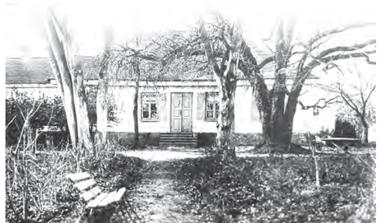
Зруйнований будинок у Колодяжному
